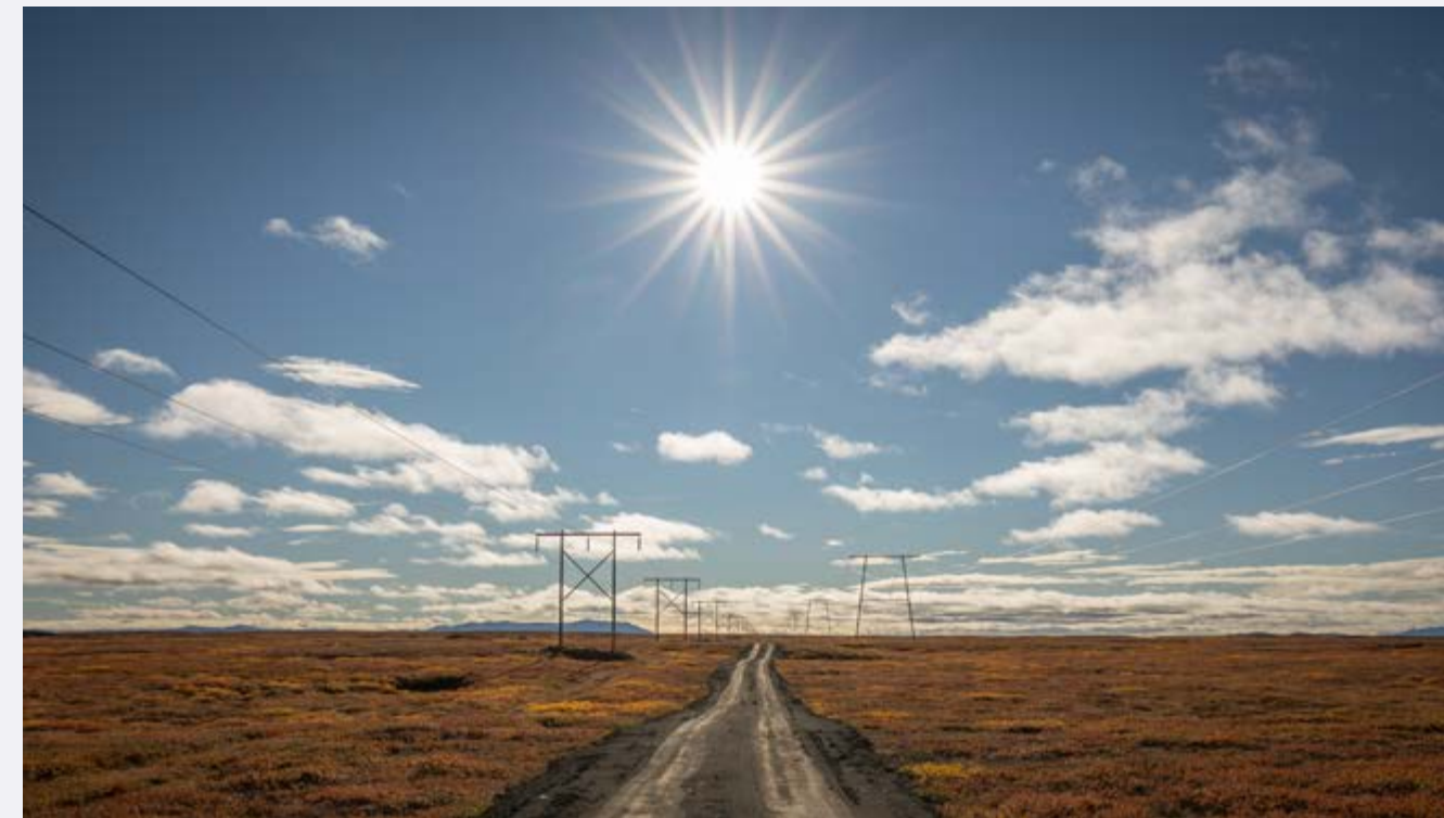
Dæmi 1. Nýleg línuslóð milli Kröflulínu 2 og 3
