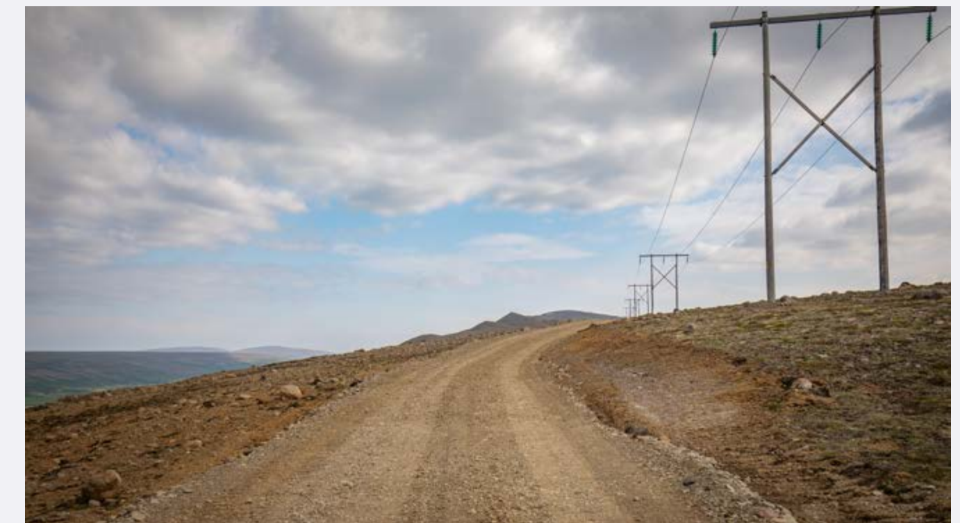
Dæmi 4. Nýleg línuslóð vegna Hólasandslínu 3
